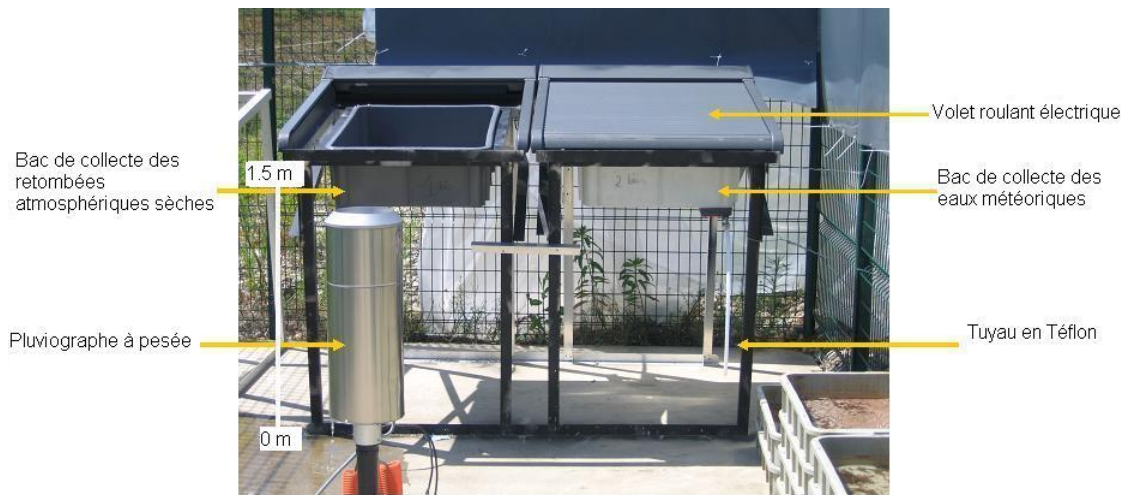
Figure 2 - Prototype d'échantillonneur des retombées atmosphériques sèches et des eaux météoriques installé à Chassieu (ici en position temps sec)
